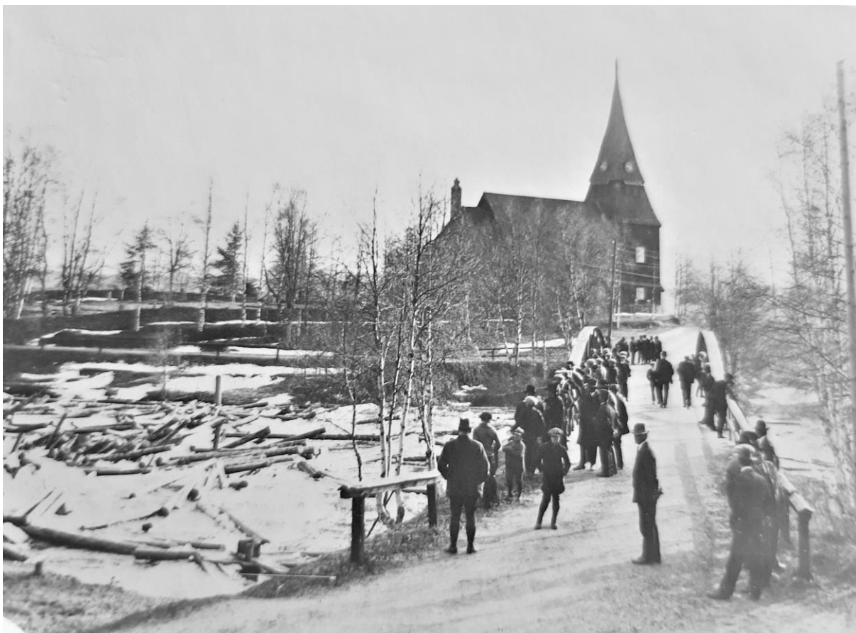
Bröt av stockarmerad is som bildade en propp som riskerade att ta med bron i Venjan. Samma sak hände i Tandö men också senare av is i Äppelbo och i Öje.
